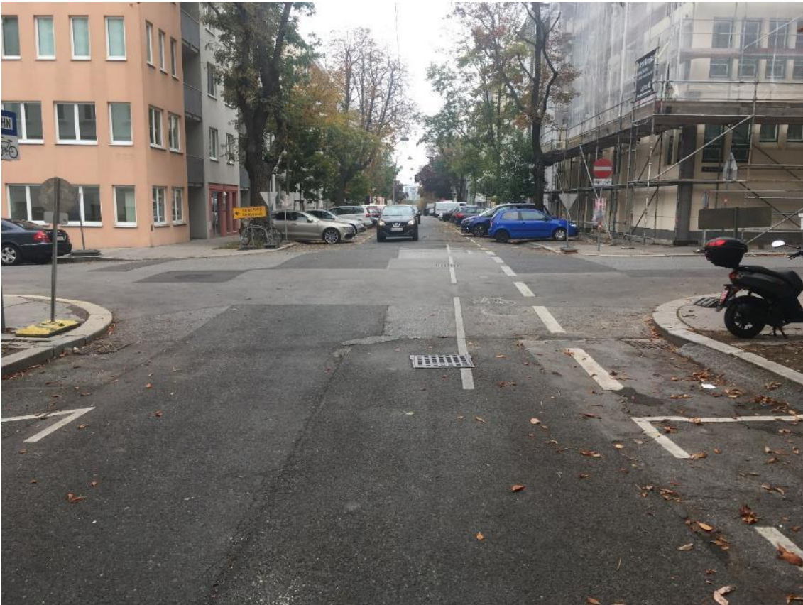
Abbildung 14: durchgezogene Leitlinien trotz Nachrangs (Rechtsvorrang) für den Radverkehr gegen die Einbahn, Kreuzung Zeillergasse # Urbangasse
