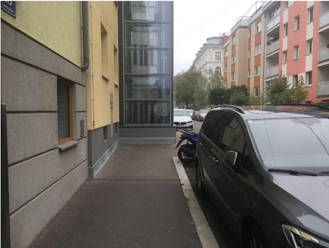
Abbildung 6: nachträglich errichteter Aufzug in der Gehlinie des Fußverkehrs ohne ausreichende Verziehung, Lascygasse ONr. 15
