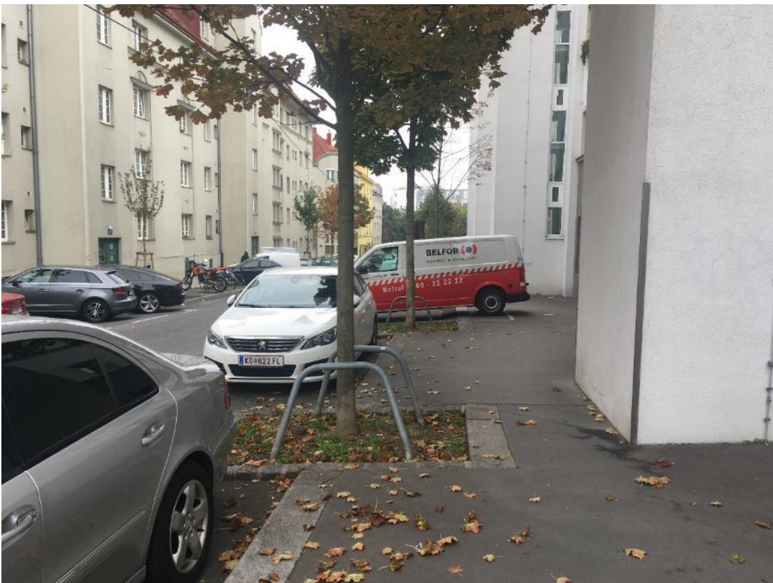
Abbildung 7: nachträglich errichteter Aufzug in der Gehlinie des Fußverkehrs ohne ausreichende Verziehung, Zeillergasse ONr. 7-11
